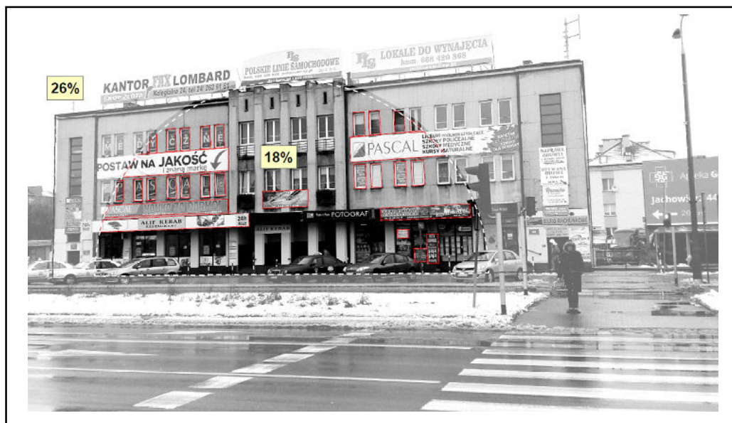
Rysunek 5. Analiza przeciężenia wizualnego reklamą zewnętrzną wykonana dla budynku dawnego Dworca Autobusowego z pozycji pierwszego obserwatora (elewacja trzejelementowa). Zgodnie z obliczeniami wskaźnik powierzchni reklam do powierzchni całej elewacji oraz stosunek powierzchni reklam w polu widzenia do powierzchni tego pola są mniejsze od 30%, reklama jest więc elementem znaczącym w ujęciu ilościowym. W kryterium jakościowym uwagę przykuwają duże rozdrobienie i mnogość reklam, które różną kolorystyką oraz często o złym standardzie jakościowym szpecą elewację starego budynku. Dyskomfortem dla obserwatora są także reklamy usytuowane na dachu budynku. Przypadek ten jest analogiczny do wspomnianego wcześniej przeładowania urbanistycznego, o którym mówi się na przykład w przypadku przegęszczenia zabudowy
