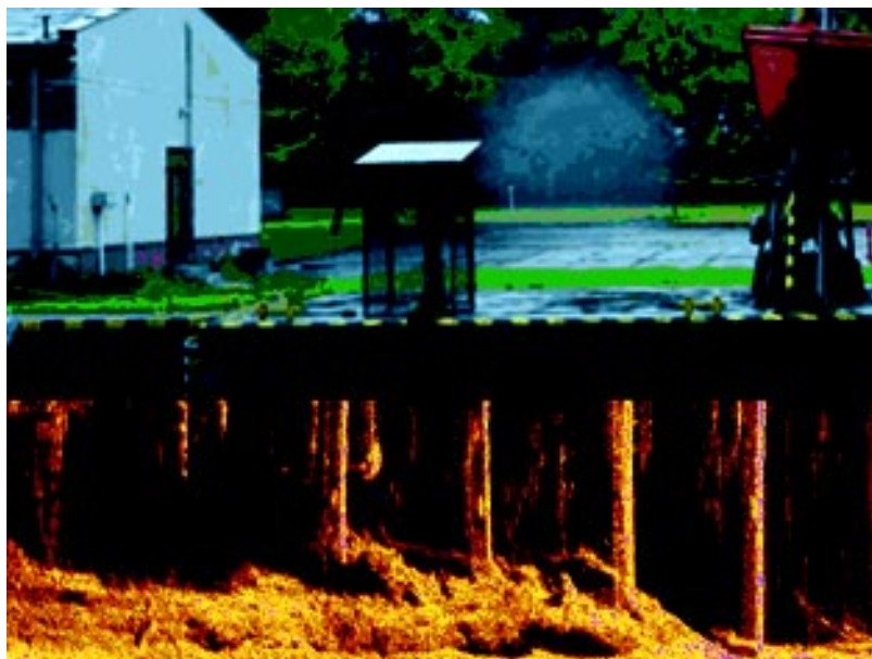
Rys. 4. Mozaika sonarowa ściany nabrzeża połączona ze zdjęciem od strony wody (opracowanie własne)
