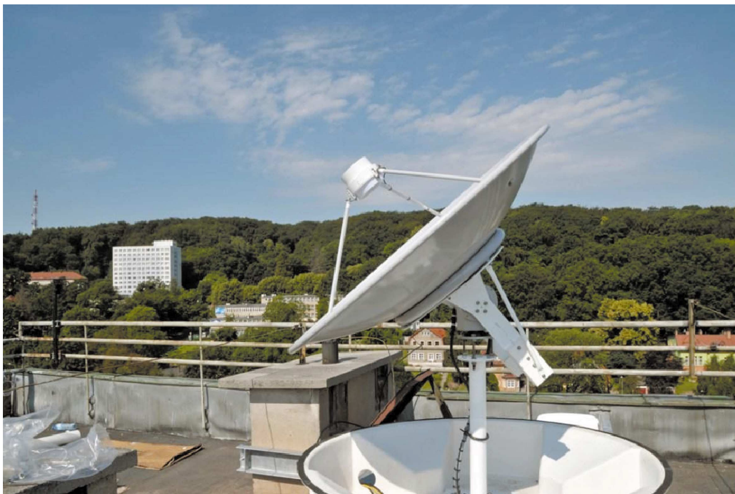
Rys. 5. Satelitarna stacja naziemna Model 1.5 HRPT/SeaWifs/CHRPT/AHRPT
