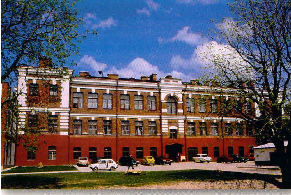
Rys. 5. Budynek PWSZ w Chełmie, wybrany do założenia anteny dla RTK DGPS
